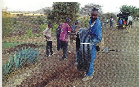
Bau der dringend benötigten Wasserleitung.
